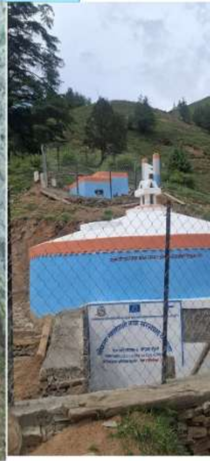
५०००० ली RCC टा
